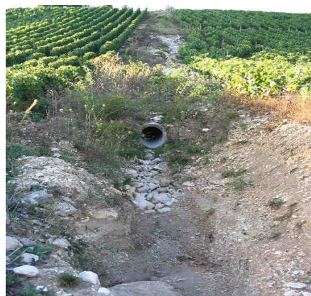
Dans le secteur de Vaucoupin, des aménagements hydrauliques de type buses ont été réalisées afin d'éviter une érosion trop importante dans les rangs de vigne.
