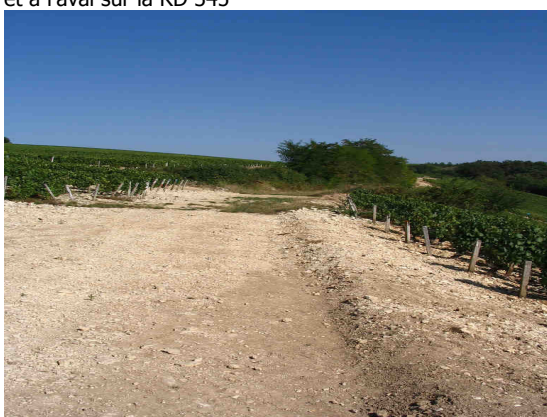
Nécessité de stocker l'eau lors des fortes pluies et d'enherber les chemins viticoles
