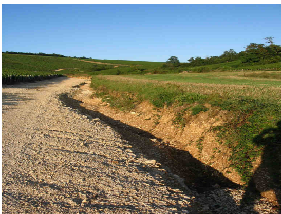
Le ruissellement crée des ornières au niveau du fossé le long du chemin viticole dans le secteur de Vaucoupin.
