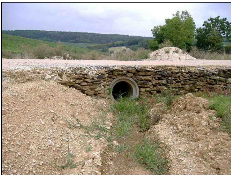
Photo 3 : exutoire de type fossé busé, à Beine
